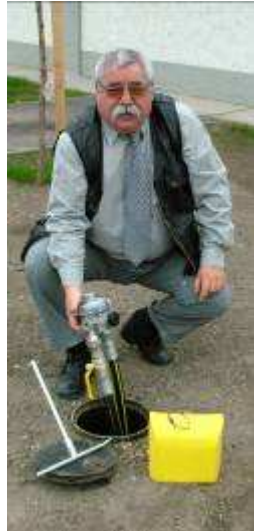
Telekhatáron belül, lehetőleg annak közelében elhelyezett, földbe süllyesztett és üzemkészen kiemelhető kivitelű, illetve részben térszint alá telepített házi gáznyomás-szabályozó állomások
