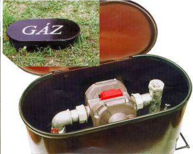
Telekhatáron belül, lehetőleg annak közelében elhelyezett, földbe süllyesztett és üzemkészen kiemelhető kivitelű, illetve részben térszint alá telepített házi gáznyomás-szabályozó állomások
