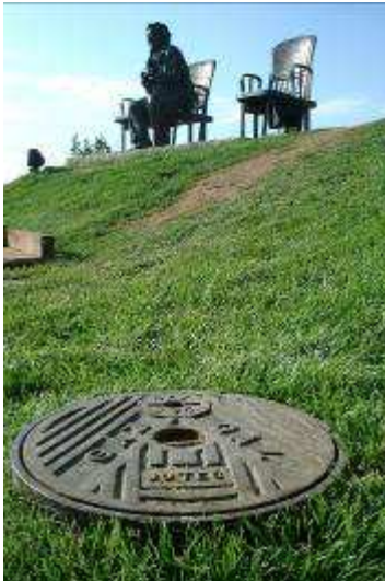
Telekhatáron belül, lehetőleg annak közelében elhelyezett, földbe süllyesztett és üzemkészen kiemelhető kivitelű, illetve részben térszint alá telepített házi gáznyomás-szabályozó állomások
