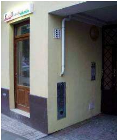
Szellőzőkürtővel fokozottan védett egyedi gáznyomás-szabályozó elhelyezése kapualjban
